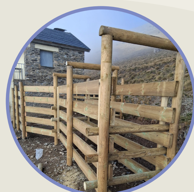
Millora i arranjament de les infraestructures ramaderes
